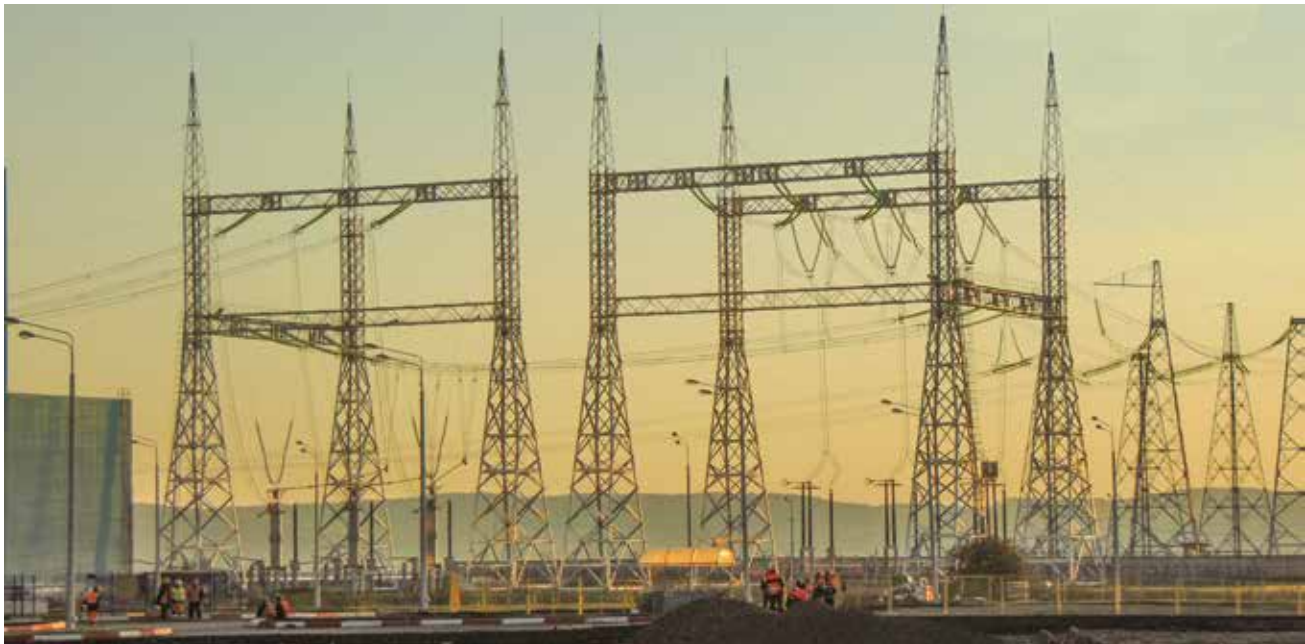
Шинная сборка (ШС-2) — ОРУ-500кВ
