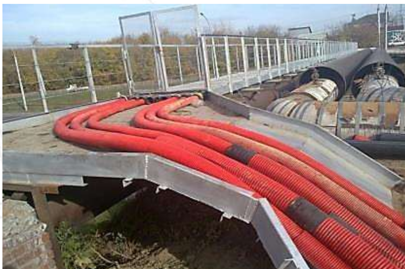
Рис. 8.1.7. Двухцепная КЛ 110 кВ С-15/16
