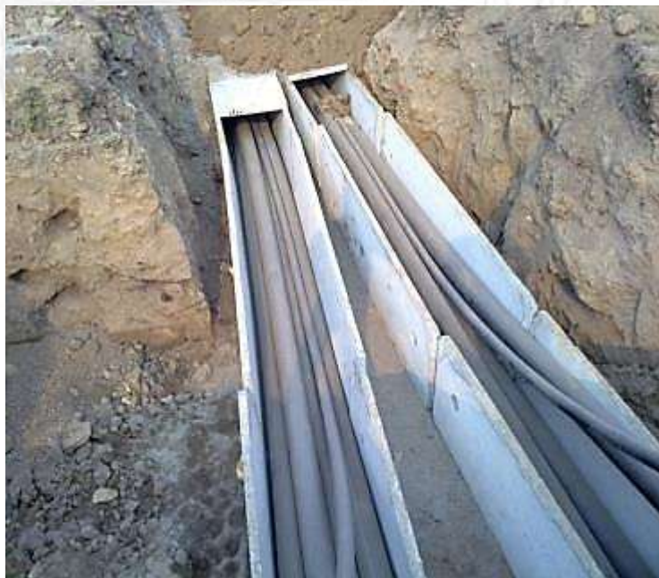
Рис. 8.1.9. Кабельная канализация.
