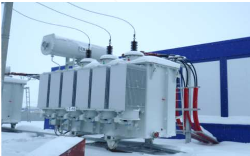
Рис. 8.1.6. Силовые трансформаторы ПС 35/20 кВ ПЛП.
