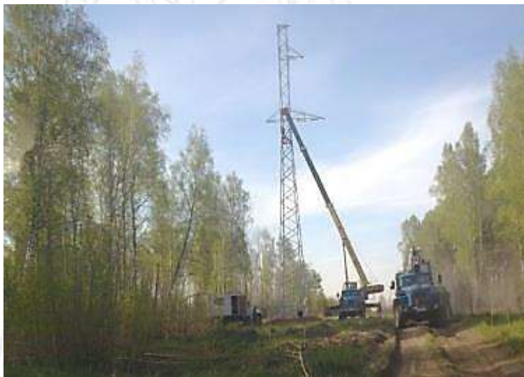
Рис. 8.1.8. Работы по монтажу и установке опор ВЛ 110 кВ Ю-8
