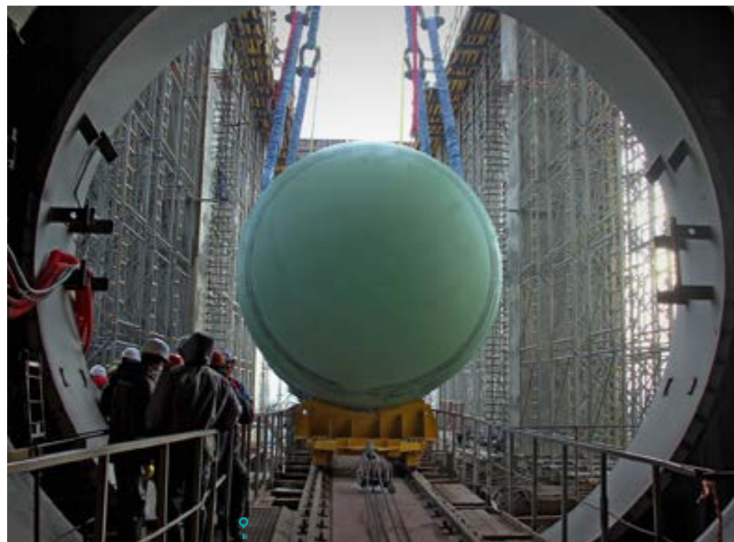
Установка корпуса второго блока на Белорусской АЭС
